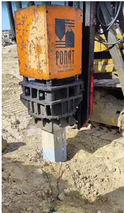
Фото 3. Процесс подготовки к испытаниям
